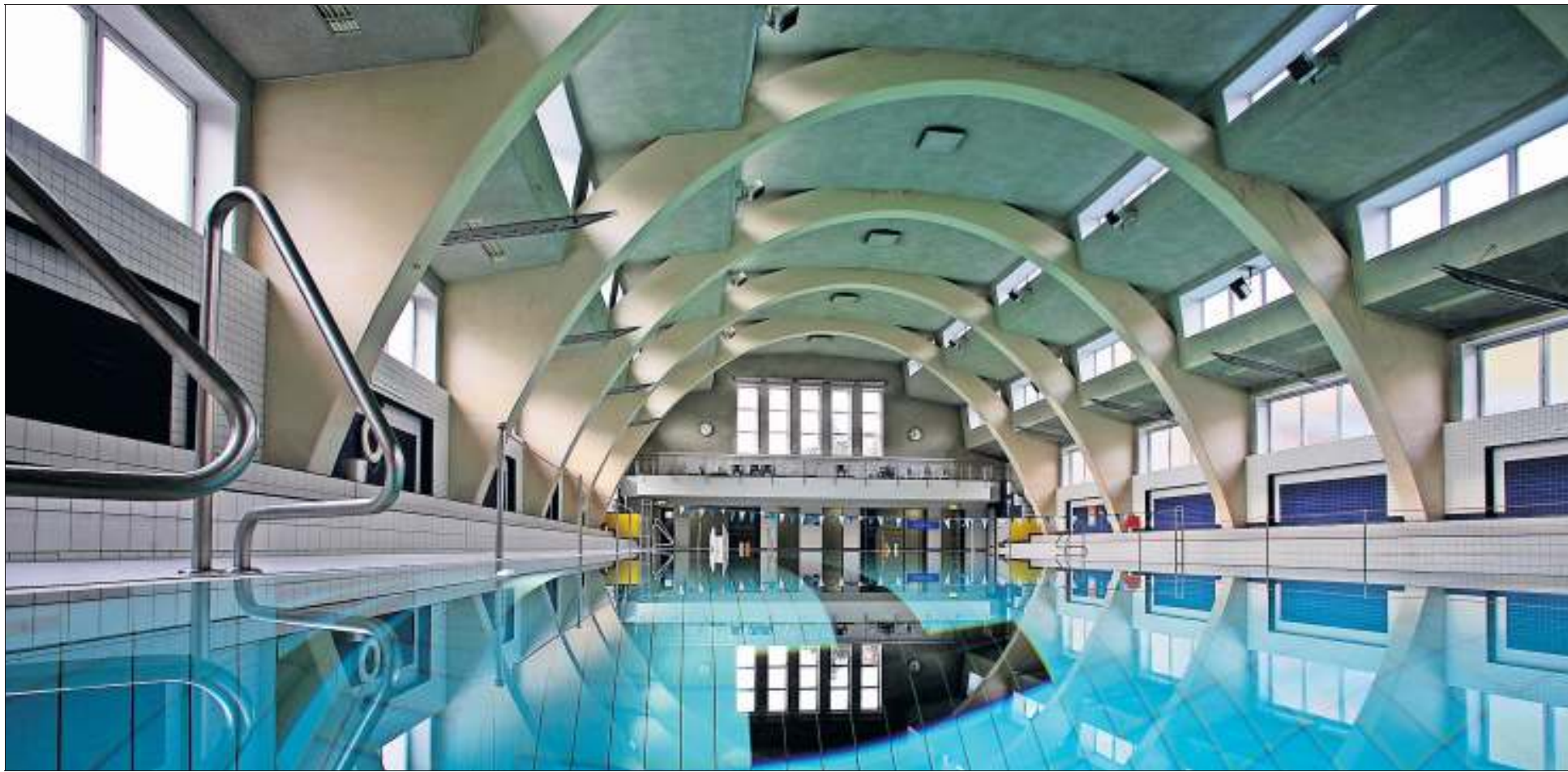
Das Bad ist bereits 1991 saniert worden. Damals wurde das 50-Meter-Becken aufgeteilt in ein Sprung-, ein Kinder- und ein 25-Meter-Schwimmbecken.
